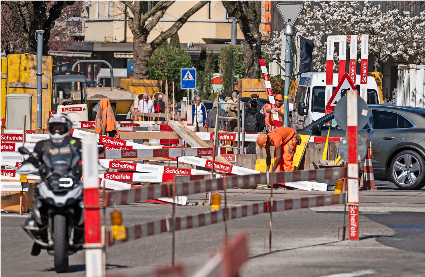
Grossbaustelle am Lindenplatz: Das EWZ und das Tiefbauamt reissen die Altstetterstrasse auf. Foto: Urs Jaudas
